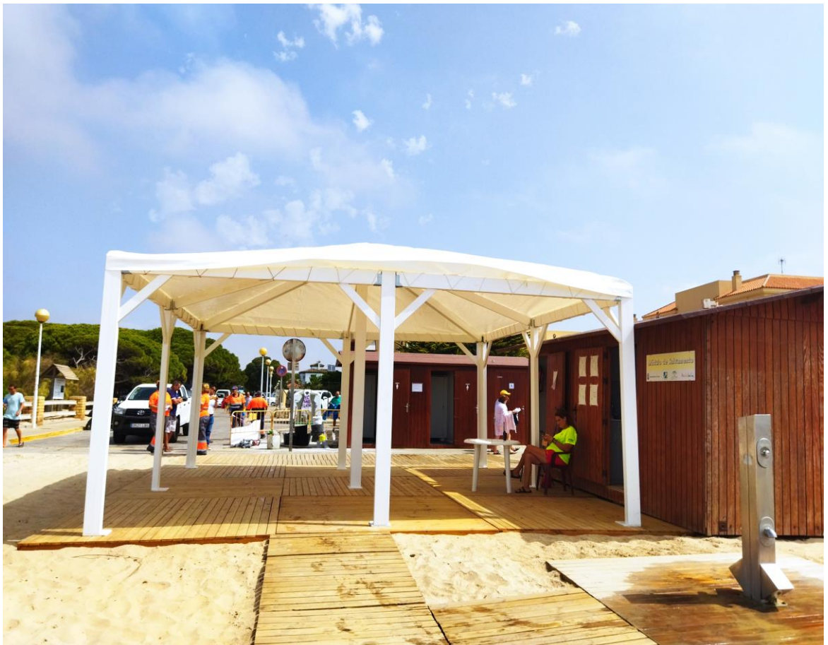
Fotografía del punto de la Playa de los Corrales remodelado
