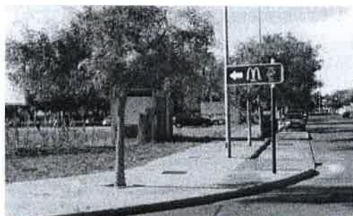
Desde la confluencia de las avenidas de la Democracia y Ecos del Rocío, vista del frente de la Manzana 13.4 hacia esta última. Tras el árbol de primer término el centro de transformación, existente en la parcela.
