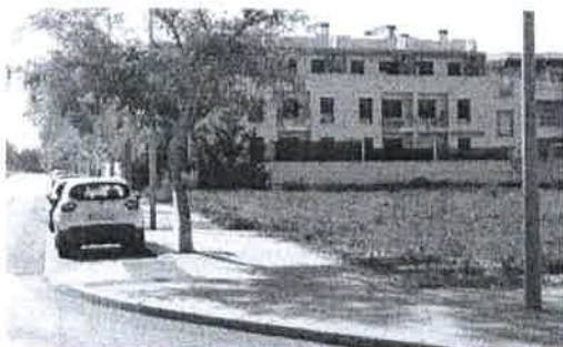
Desde la confluencia de las avenidas de la Democracia y Ecos del Rocío, vista del frente de la Manzana 13.4 hacia la primera.
